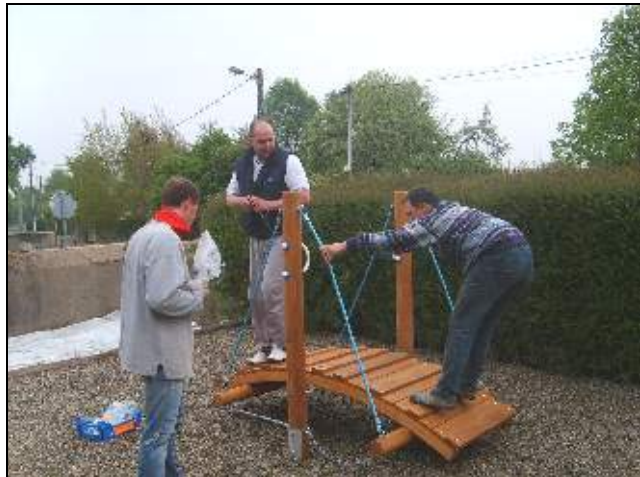
Après l'assemblage, on teste la résistance de l'installation...
