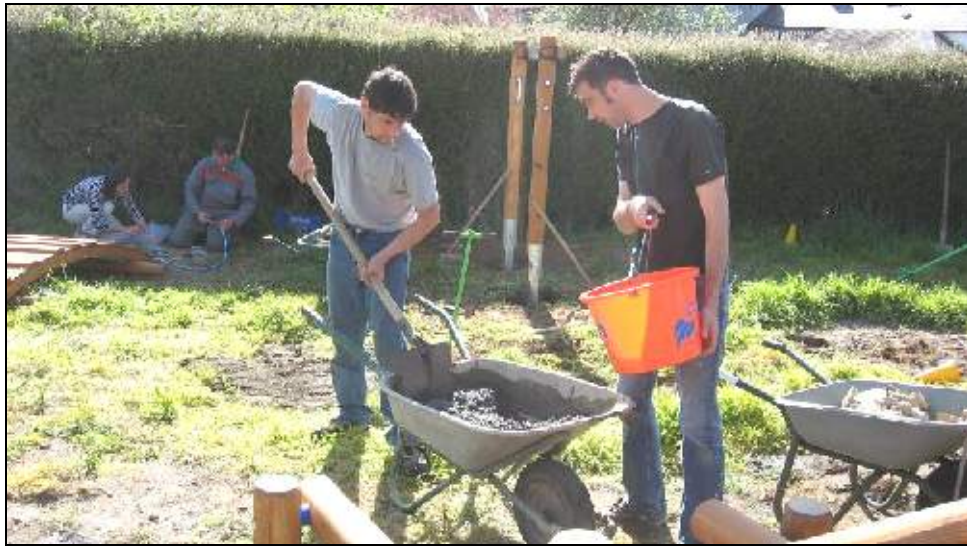
Préparation des fondations
