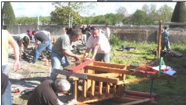
Les structures sont montées, on va pouvoir les installer
