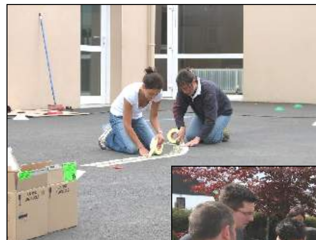
Les caches à l'adhésif permettront de peindre la route automobile sans déborder.
